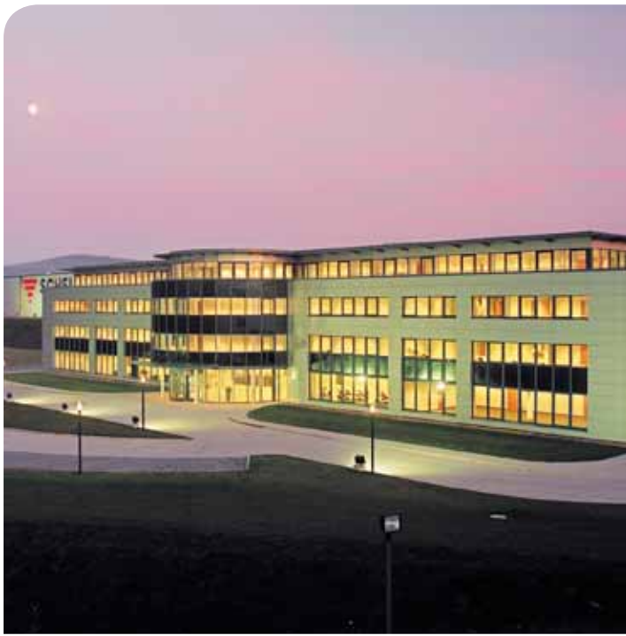
Planta 1 – Producción con edificio de administración y centro de formación
