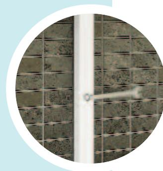
② Para facilitar la regulación, la sección vertical de la abrazadera incluye una marca bien visible para señalar la altura.
