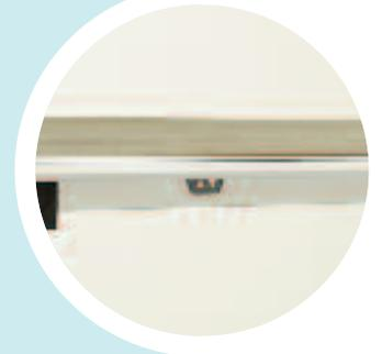
③ Las encimeras de cocina con altura regulable eléctricamente deberían contar con barras de seguridad para evitar lesiones por aplastamiento.
